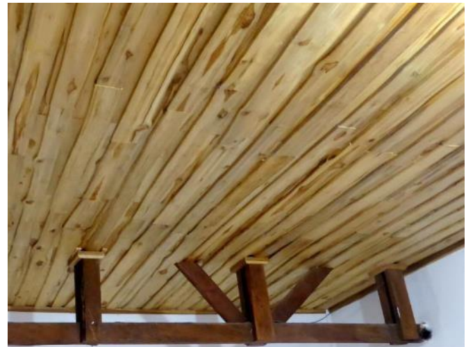
Para evitar problemas con fisuras, un diseño de cielo con traslape entre las tablas, y cada tabla se fija de manera independiente sobre la regla de soporte.
